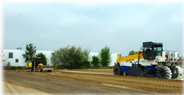
Klop Vianen grondverbetering
