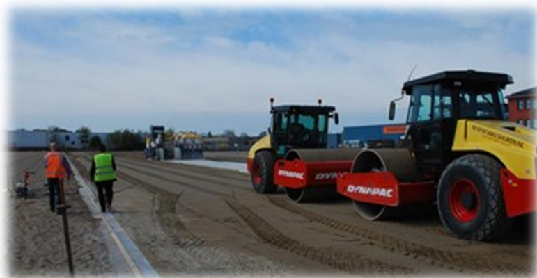
Verdichten en profileren
